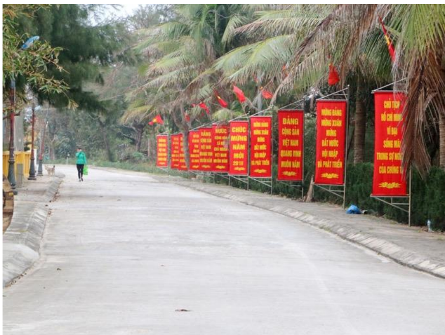
Hình 4.1: Đường giao thông trên đảo đã được bê tông hóa
