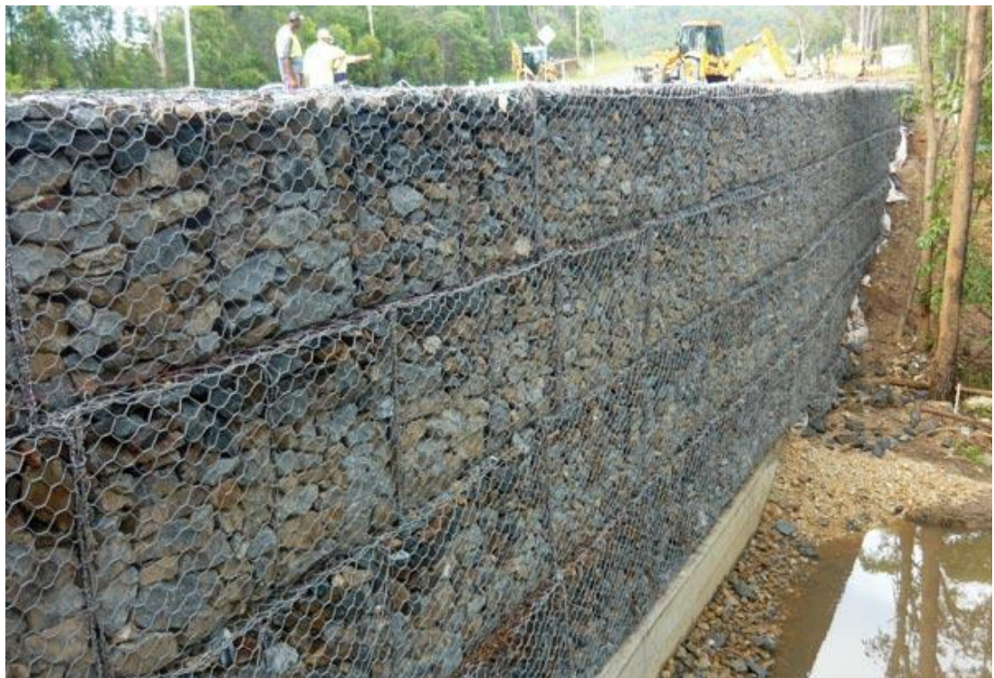
Hình. Tường chắn được làm bằng rọ đá xếp bên ngoài
