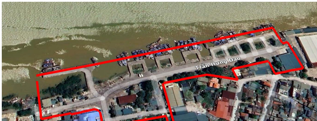
Vị trí khu vực thi công gia cố bờ kè phía sông của TDA Lạch Hới
