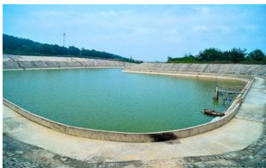
Hình 2.19. Hồ chứa nước ngọt có dung tích 45.000 m 3 và Nhà máy cấp nước sinh hoạt cho người dân trên đảo Bạch Long Vĩ với công suất 15m 3 /giờ
