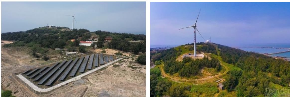
Hình 2.26. Công trình điện năng lượng mặt trời và điện gió được lắp đặt trên đảo
