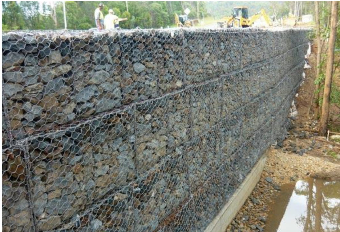
Hình 2. Tường chắn được làm bằng rọ đá xếp bên ngoài
